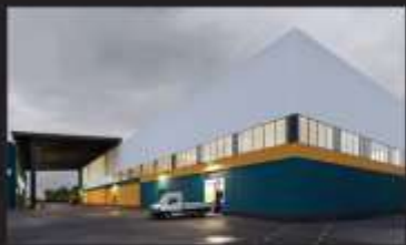
в процессе строительства Обувная фабрика «Техновизия» Ижевск-Ола, 2024
