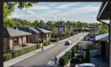
в процессе строительства Коттеджная застройка с. Овстеево, 2022
