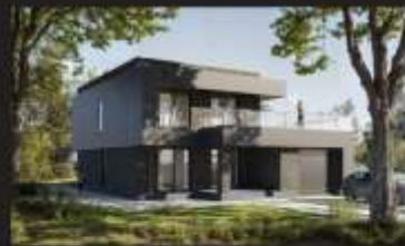
в процессе строительства Частный жилой дом Москва, 2023
