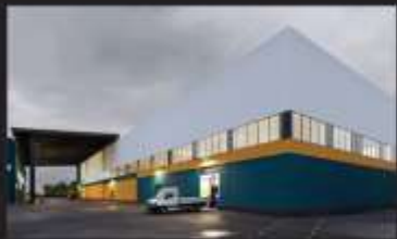
в процессе строительства Обувная фабрика «Техновизия» Ижевск-Ола, 2024
