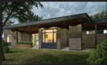
в процессе строительства Частный жилой дом Ижевск-Ола, 2021
