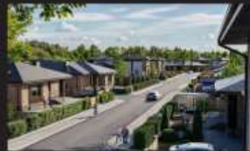
в процессе строительства Коттеджная застройка с. Овстеево, 2022
