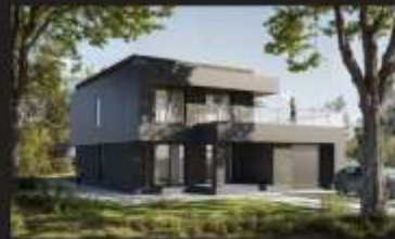
в процессе строительства Частный жилой дом Москва, 2021
