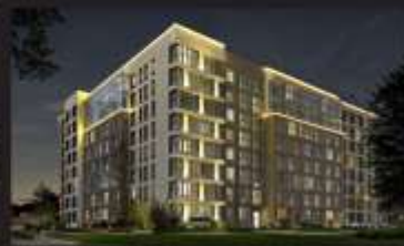
в процессе строительства Жилой дом Новый Уренгой, 2022
