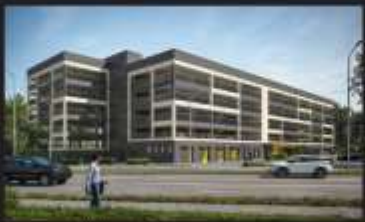
в процессе строительства Паркинг на 450 машино-мест Минск, 2021
