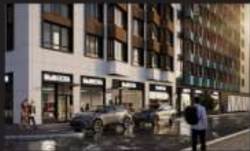
в процессе строительства Жилой дом на ул. Сибирской Новый Уренгой, 2024
