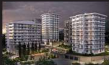
в процессе строительства Жилые дома на ул. Левитана Алушта, 2024
