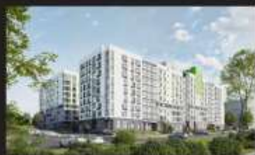
в процессе строительства Жилой комплекс на ул. Строганова Тамбов, 2023
