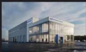
в процессе строительства Автосалон Daewoo Trucks Архангельск, 2023
